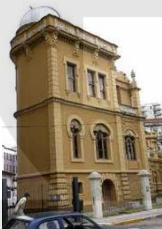
Prédio do Observatório Astronômico de Porto Alegre (Propriedade da UFRGS).
