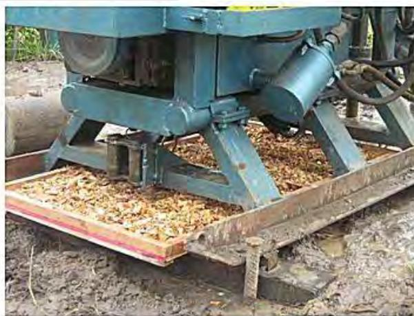
Preservação do solo, subsolo e mananciais, caixa de serragem para contenção de possíveis vazamentos do equipamento (motor da sonda rotativa).
