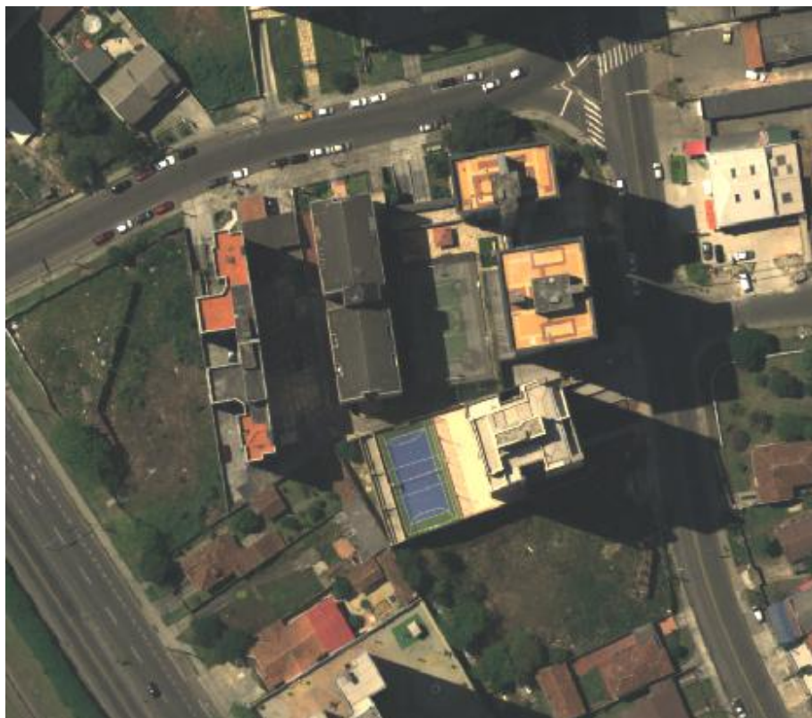
Fig 16: Verticalidade de Prédios - Curitiba
